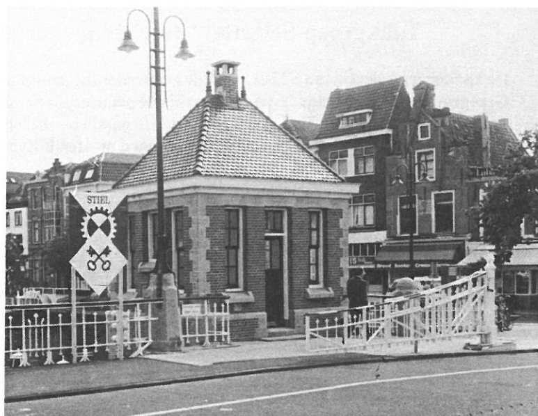
De machinekamer van de Blauwpoortsbrug zal op beide Monumentendagen geopend zijn, met uitleg door STIEL-vrijwilligers
