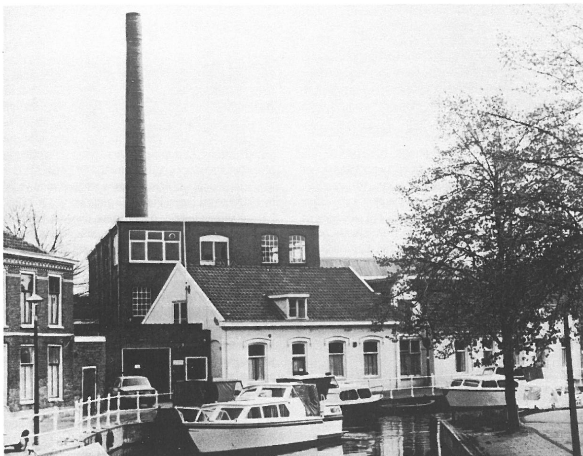
Ingang van het complex aan de Schelpenkade
