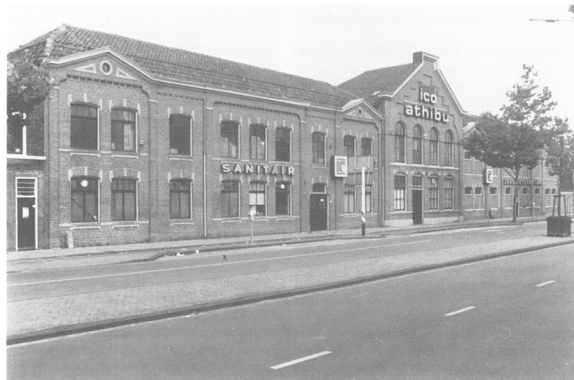
De voormalige textielfabriek 'Parmentier' aan de Langegracht werd in 1993 gesloopt.
