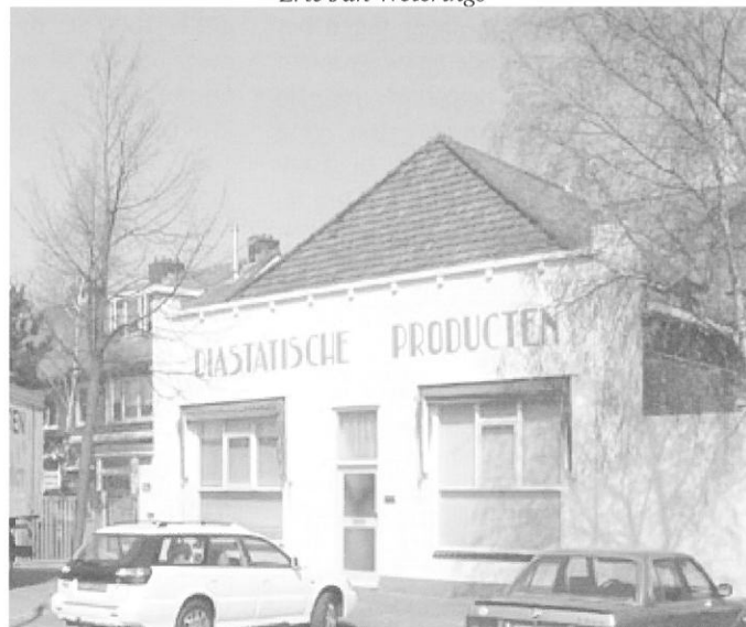
Vooraanzicht van het kantoorgebouw.
