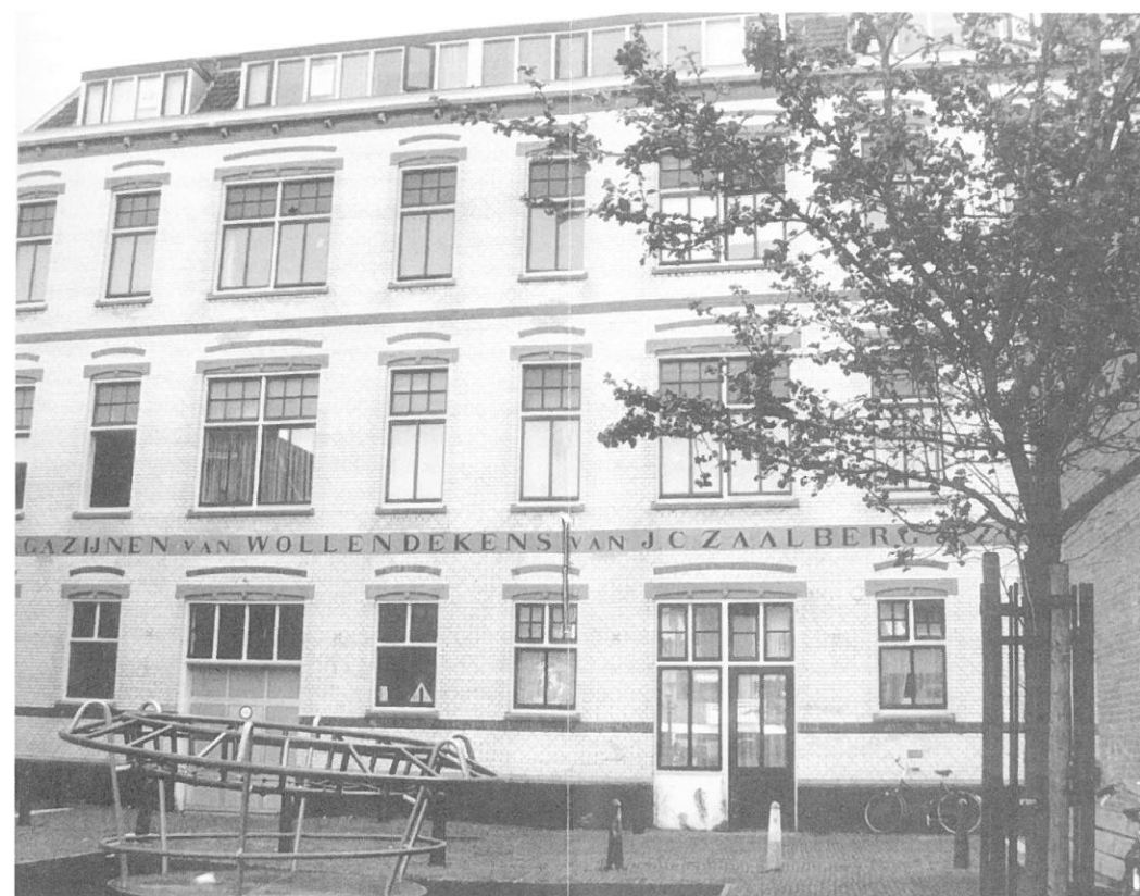
Een recente foto van het Zaalberg-complex aan de Vestestraat.
