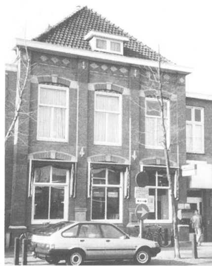
Het oude postkantoor van Hillegom, nog steeds in gebruik.
