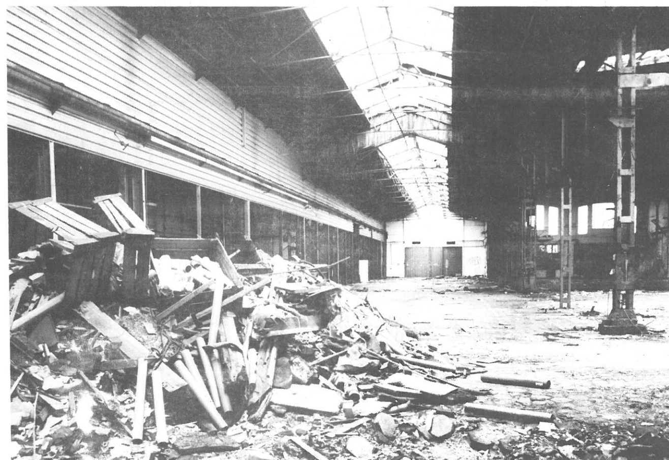
De sloop van een van de HCG-hallen in juni 1992.
