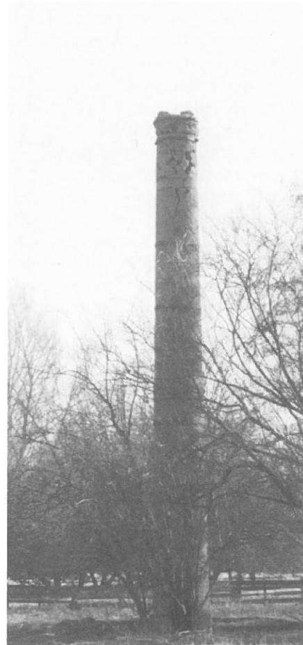
De nogal gehavende schoorsteen van een voormalig kassenbedrijf in Roomburg.
