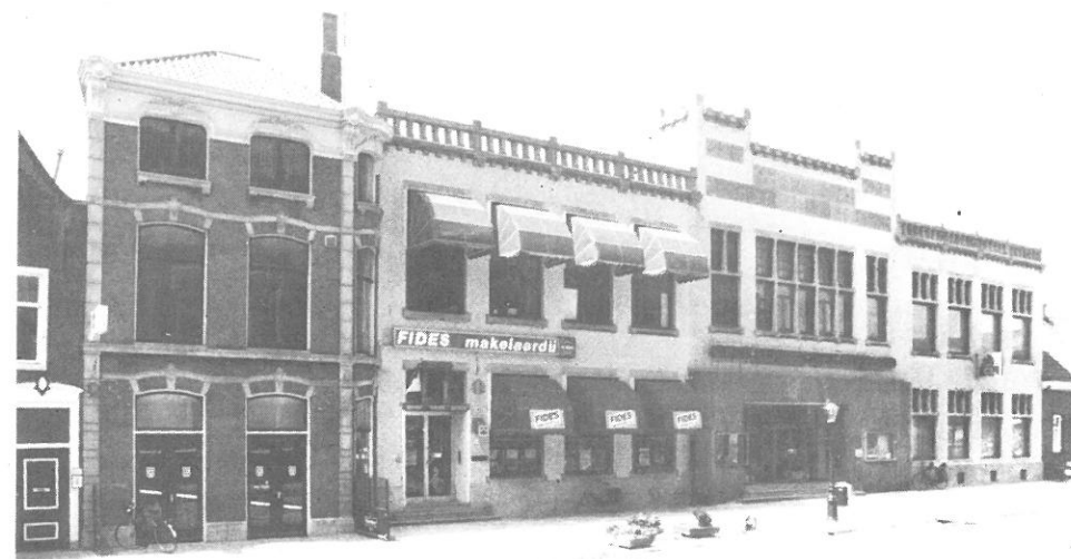
Het voormalige Sijthoff-complex aan de Doezastraat.
