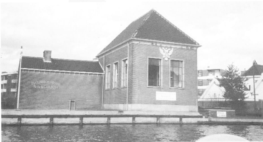
Het gemaal in Leidschendam.
