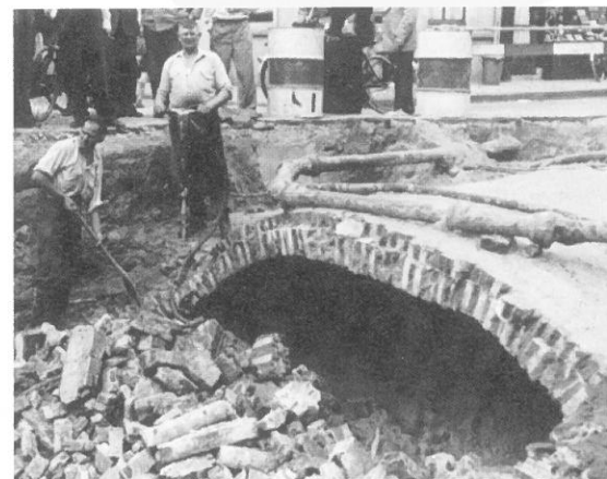
Het wegbreken van het oude rioolgewelf onder de Langebrug bij het Steenschuur.
