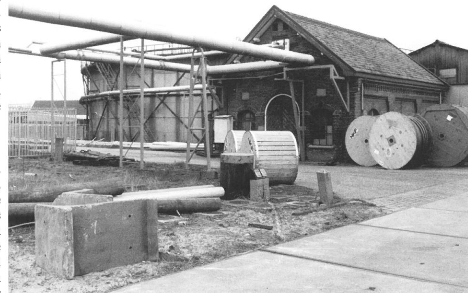
Het ketelhuis van de Leidse gasfabriek uit 1904
