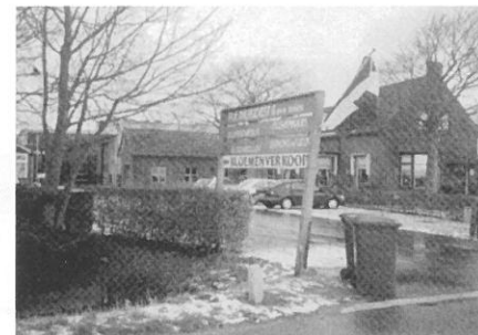
Firma Overdevest, Katwijkseweg 19. Bij de sloop twee jaar geleden van de oude bollenschuur van deze firma was de draagfunctie van de stellingbalken duidelijk zichtbaar.
