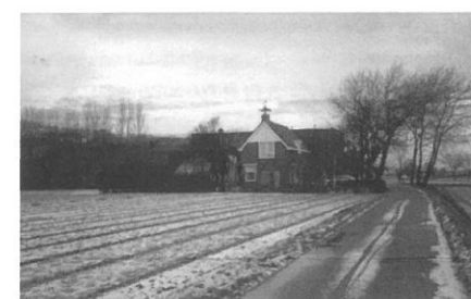
Bollenbedrijf Prins en Topper zal worden gesloopt.
