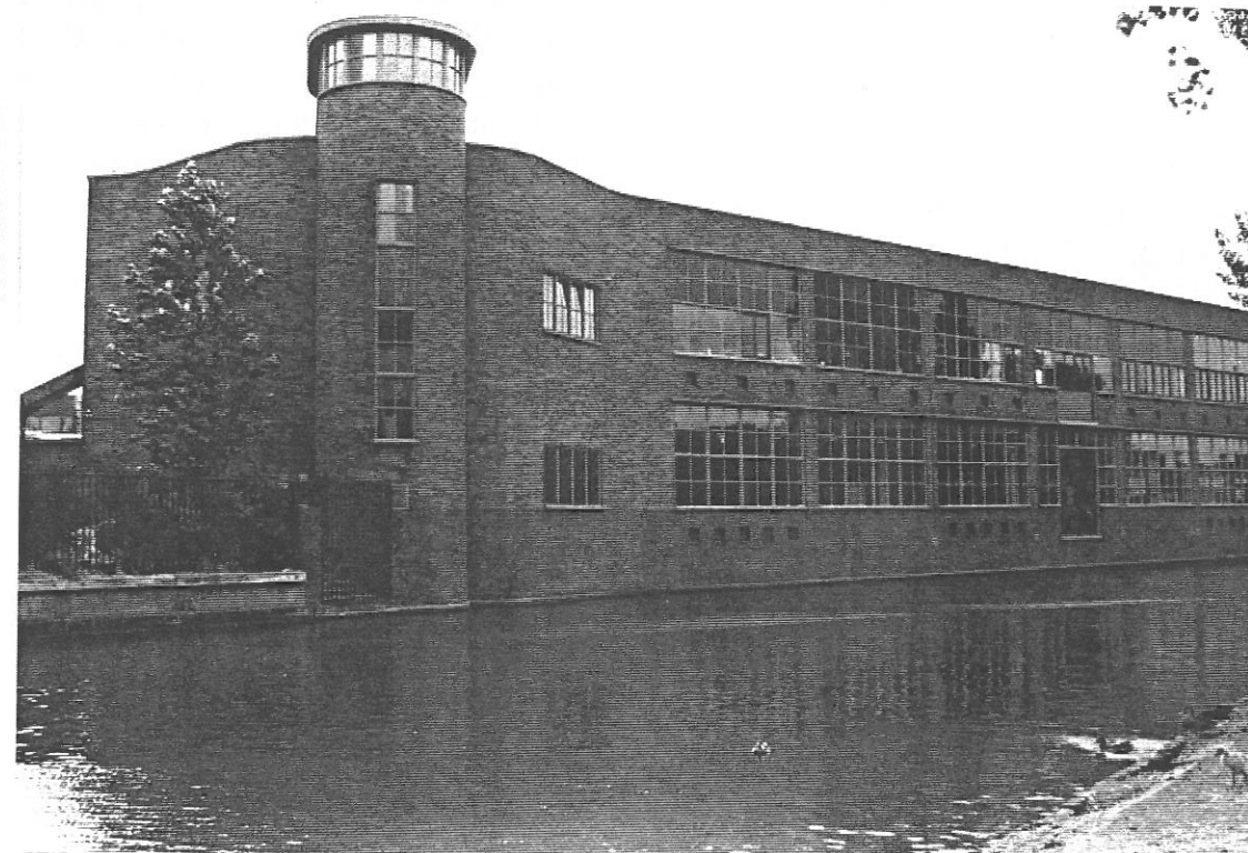
De gevel aan de Maresingel volgt de bocht in de Vestwal. Links het trappenhuis.
