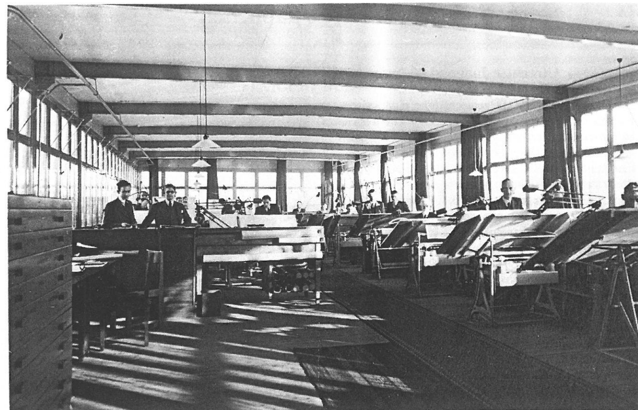
De tekenkamer van de NEM aan de Zoeterwoudseweg, kort na de oorlog. Enige maanden geleden werd dit gebouw afgebroken. (Foto bedrijfsarchief NEM)
