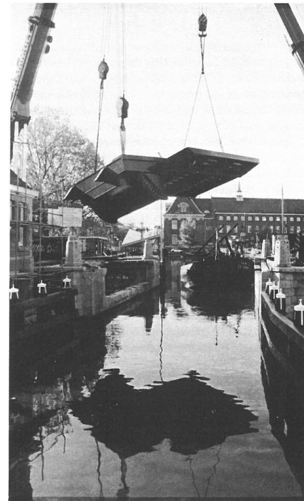
Plaatsing eerste deel rolbasculen
