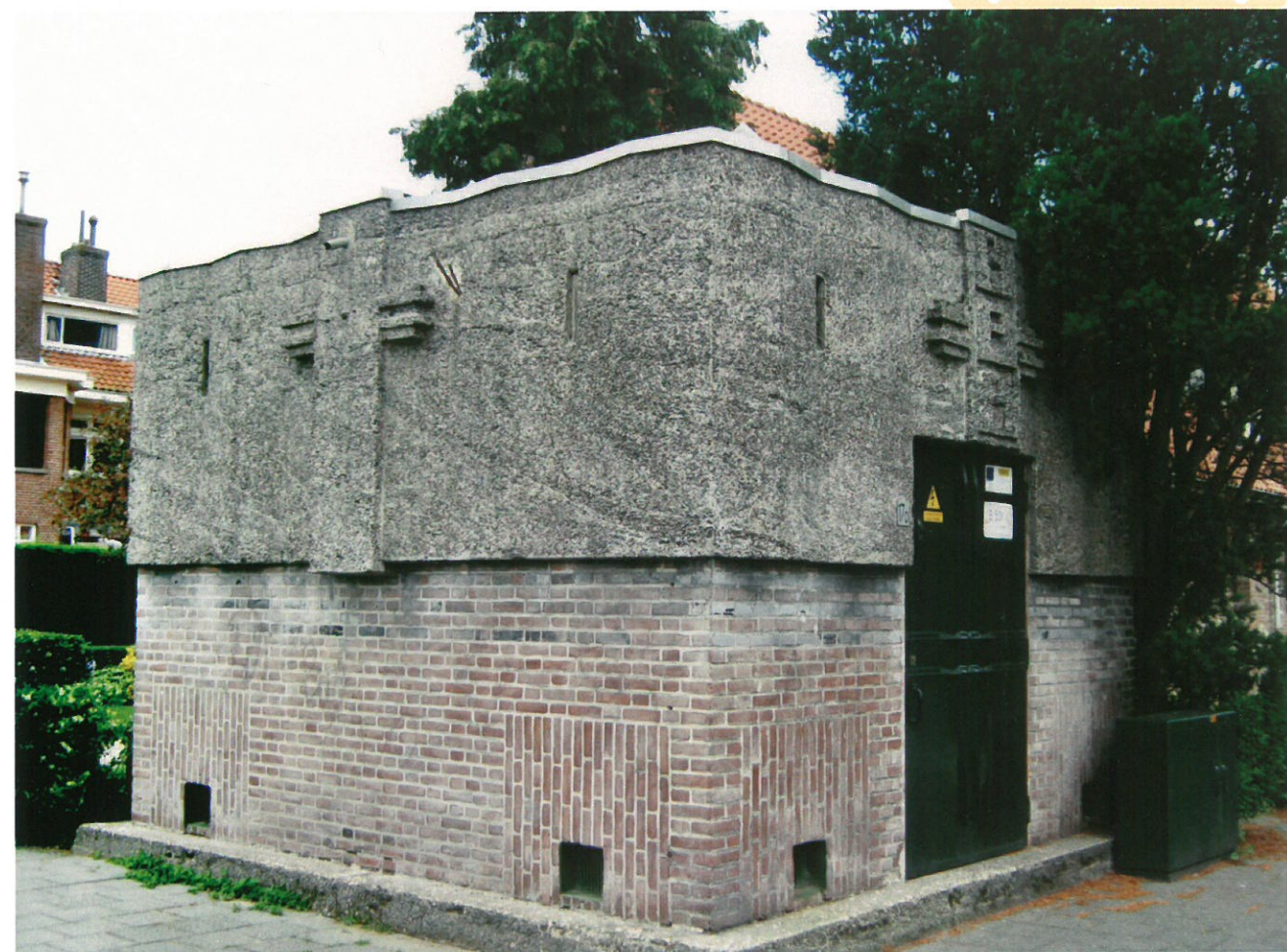
Trafohuisje in de stijl van de Nieuwe Haagse School in de Haagse wijk Marlot.
