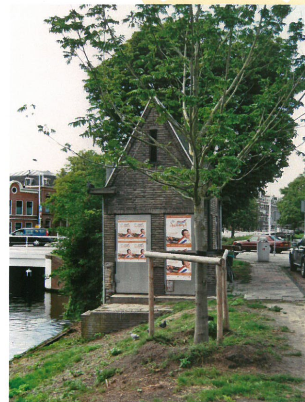
Het trafohuisje aan de Jan van Houtkade.
