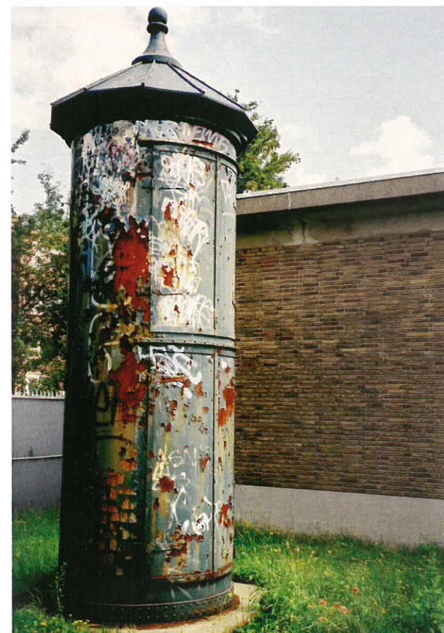
De transformatorzuil die nu op het Vrouwenkerkhof staat, nog voor de restauratie en terugplaatsing.
