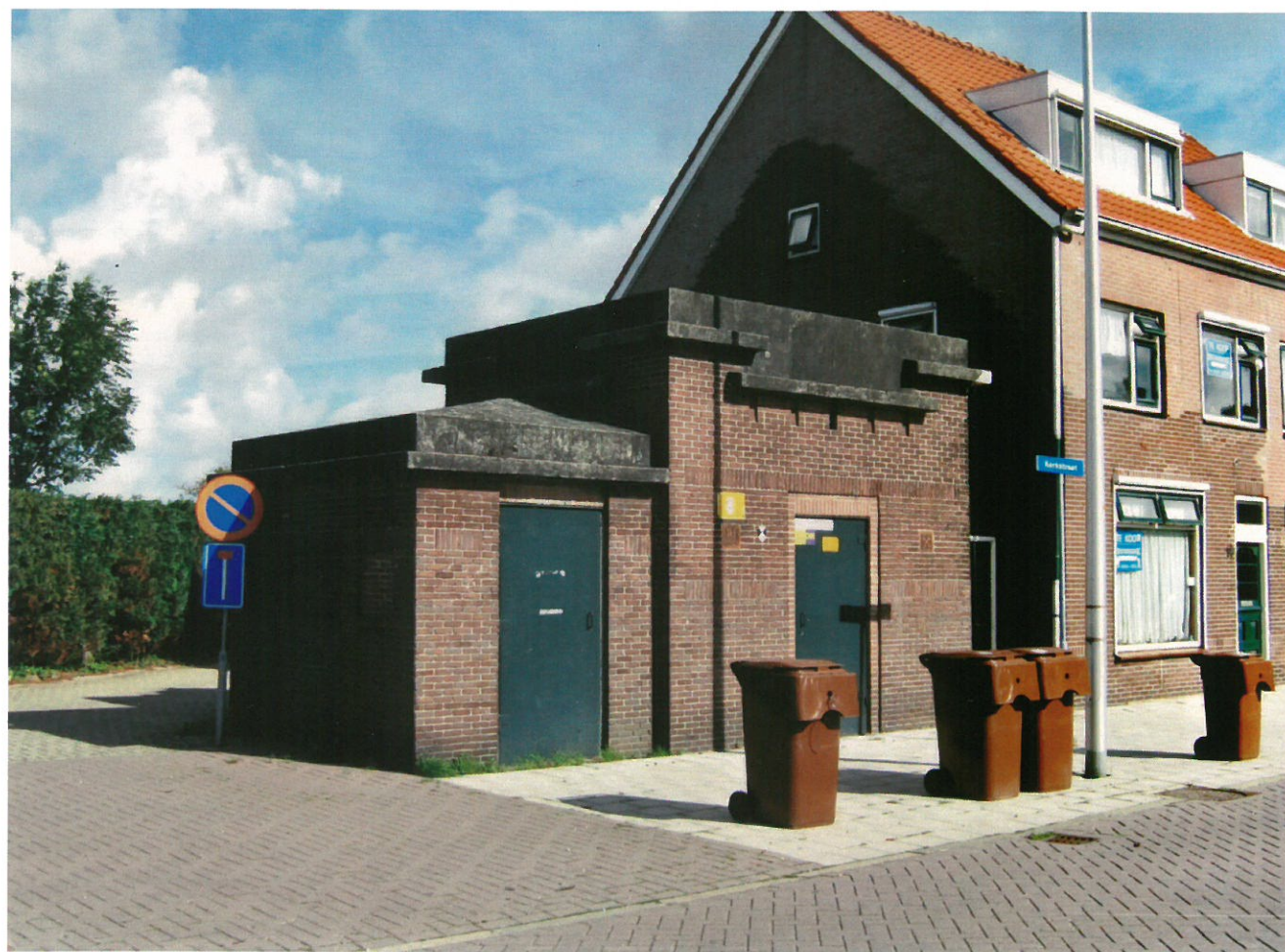
Trafogebouwtje in Noordwijkerhout, bouwjaar 1925-1928.
