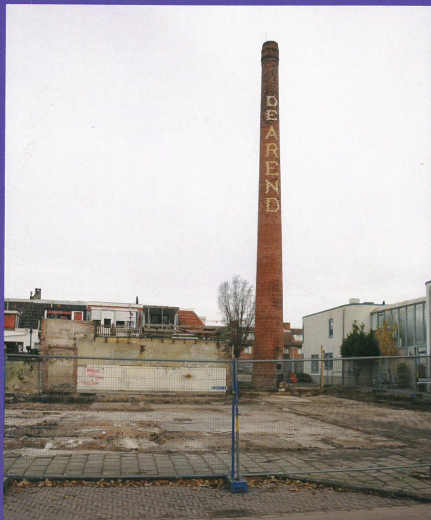
Het gebouw van wasserij De Arend is onlangs afgebroken. Alleen de schoorsteen is blijven staan. Maar deze pijp is dan ook een gemeentelijk monument. Foto: Niek Bavelaar.
