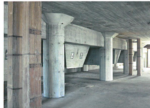
Een vloer van het zakkenpakhuis met op de achtergrond de onderkant van een eerste vorm van een meelsilo. De meelsilo is een Leidse uitvinding. Tot die tijd werd meel altijd in zakken verpakt, vervoerd en opgeslagen. Tegenwoordig wordt meel in de westerse wereld heel veel uit silo's per tankauto vervoerd.
