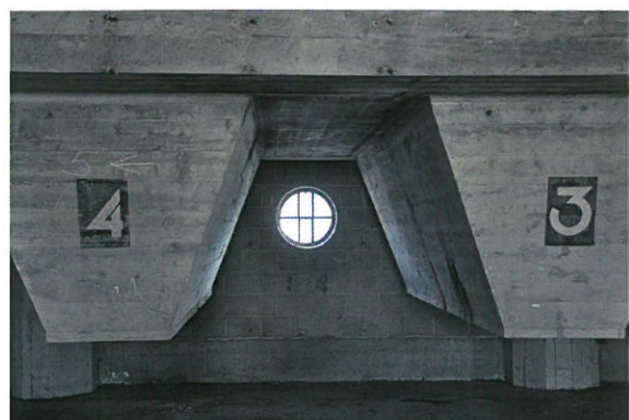
De onderkant van een der meelsilo's in het zakkenpakhuis.
