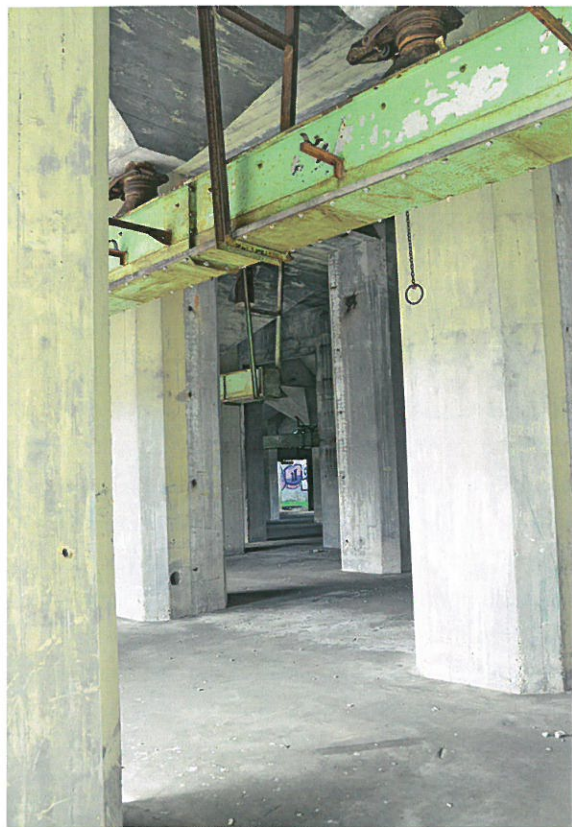
De kolommen onder de graansilo's met daartussen de trechters. De oppervlakte in betondoorsnede van deze kolommen is net zo groot als de wanden van de silo's erboven.
