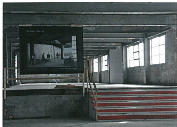
Een blik vanuit het ene molengebouw naar het andere. Op deze vloeren stonden alle machines, die het graan verwerkten tot meel. In het achterste (nieuwste) gebouw klink- en boutconstructies naast elkaar. Massief houten vloeren op staalconstructies en eromheen gevels van hollands baksteen met modernistische stalen bandramen.
