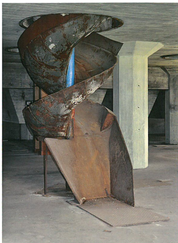
De dubbele glijgoot voor volle meelzakken in het zakkenpakhuis. Deze goot in de vorm van een dubbele schroef had op iedere vloer twee kanten (een rode en een blauwe). Op de begane grond kwam iedere kant in een vrachtauto uit. De goot werd ook gebruikt door werkers die snel beneden wilden zijn bij de pauze. Je moest dan wel zeker weten dat er een vrachtauto onder stond en dat die hoog opgeladen was, anders maakte je een lelijke smak. Op de achtergrond de achthoekige kolommen met de verbreding aan de kolomkop, die leidde tot de naam paddestoelvloeren.
