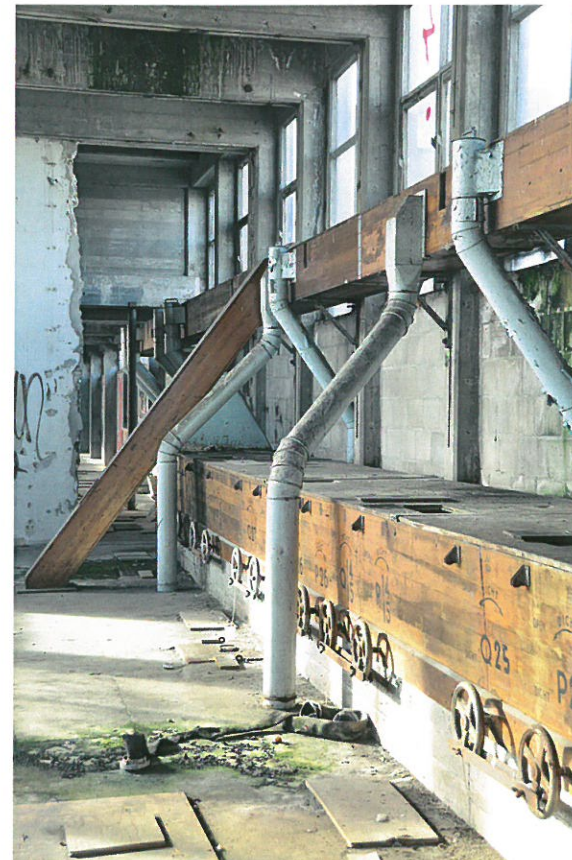
Op ruim veertig meter hoogte, bovenop de meelsilo's, het cellendek. Op de achtergrond het cellendek van de graansilo's.
