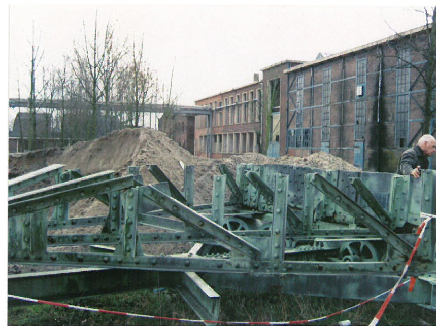
Een aantal gebouwen wordt nog water- en winddicht gemaakt. Op de achtergrond een van deze gebouwen, en op de voorgrond overblijfselen van de eerste Hembrug (1878), die begin twintigste eeuw werd afgebroken en vervangen is door een grotere brug.
