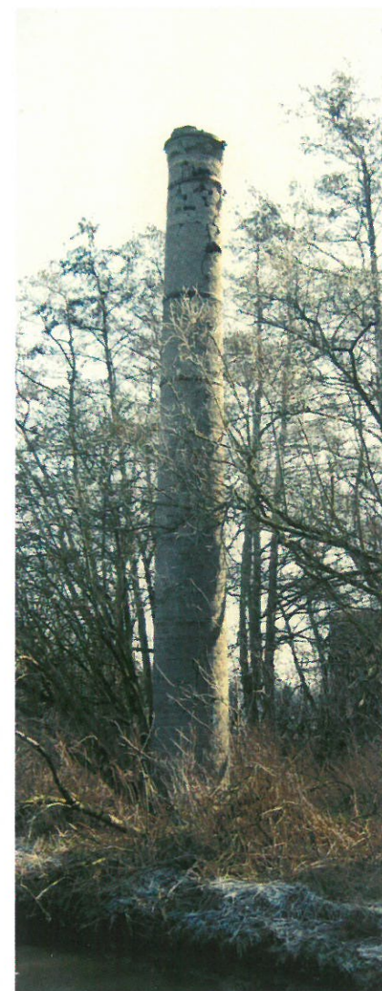
De tuinderijschoorsteen aan de Vliststraat, vóór de restauratie.
