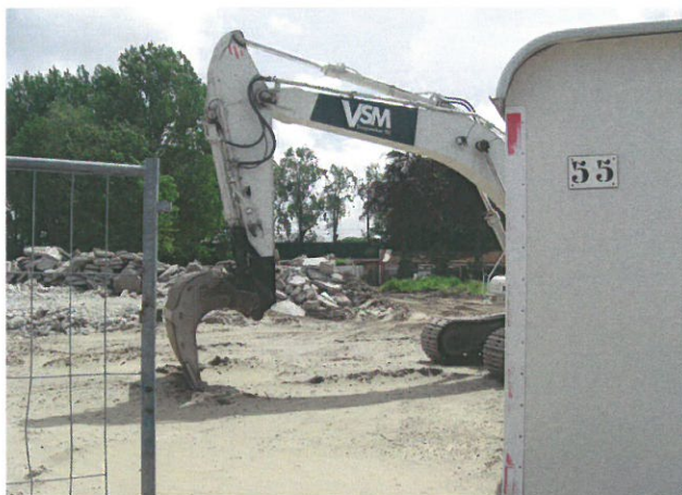
De Aardewerkfabriek van Groeneveldt in juni 2013, troosteloos na de afbraak. Foto: auteur.
