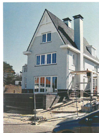
Een van de villa's in aanbouw aan de Rembrandtweg in Noordwijk aan Zee.
