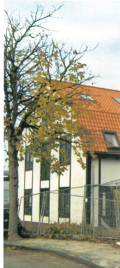
De "bollenschuur-woningen" op de Hoge Mors.
