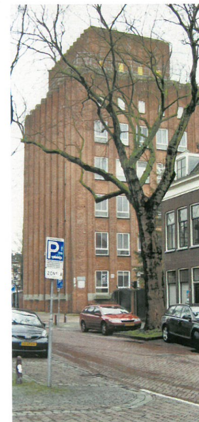
De Van der Klaauw-toren, die ten prooi viel aan de slopershamer.
