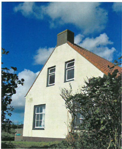
Een oude vuurtoren en een wachterswoning op het Vuurtoreneiland in het IJ.
