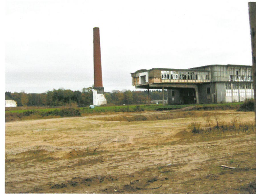
Sloop en opbouw.
