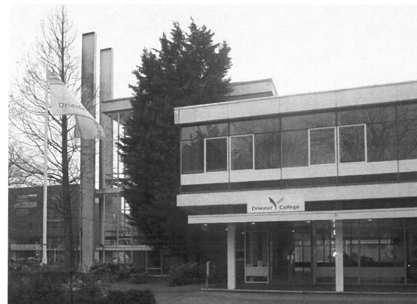
Voormalige MSG aan de Dieperpoellaan.
