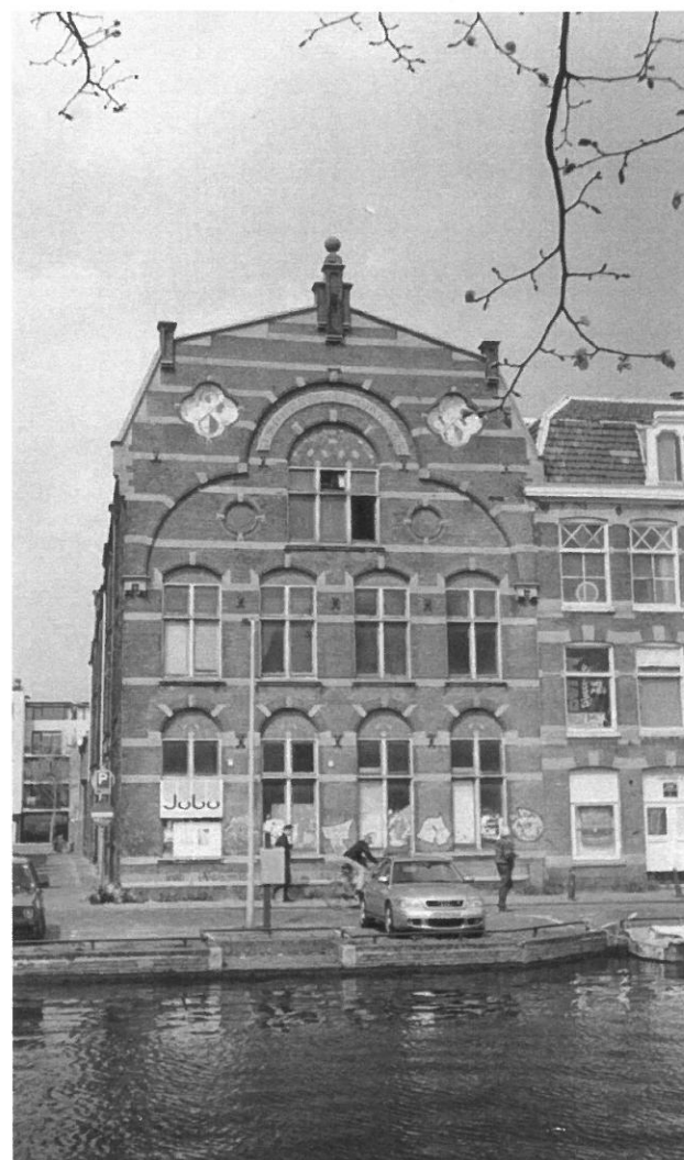
De voormalige dekenfabriek van Scheltema voor de restauratie.
