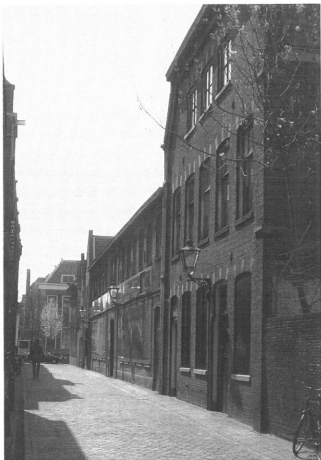
De gevelwand van de Marktsteeg blijft behouden.
