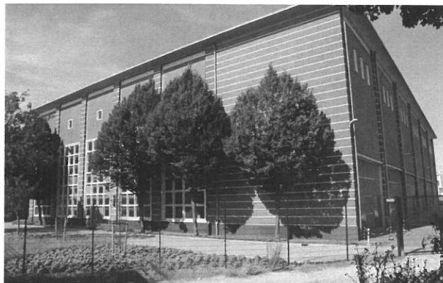
Het 50 KV-station aan de Flemingstraat.
