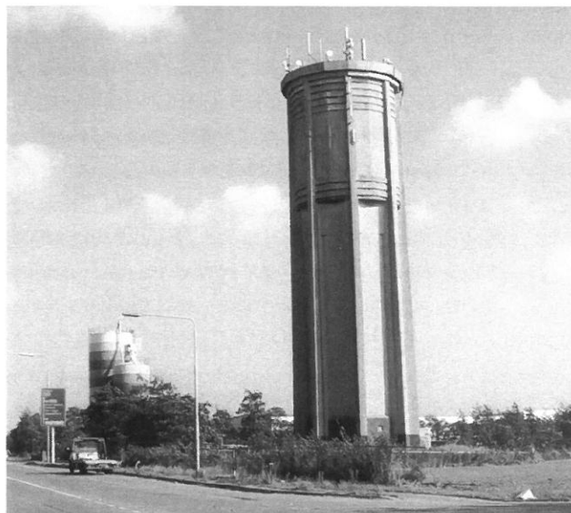
Archiefplaat van de toren van Hillegom.
