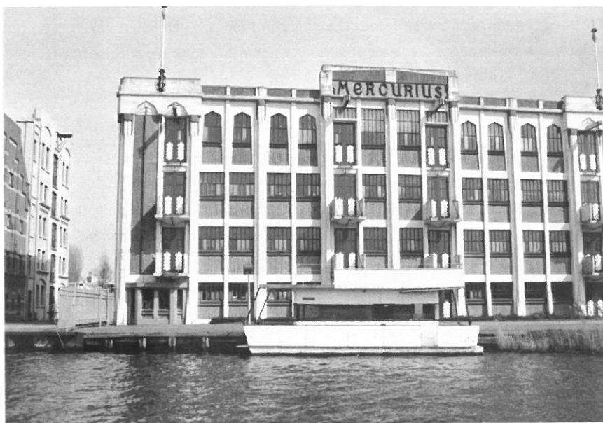
De provincie heeft het voortouw genomen bij het behoud van industrieel erfgoed. De restauratie van de rijstpellerij Mercurius kreeg een belangrijke voorbeeldfunctie.
