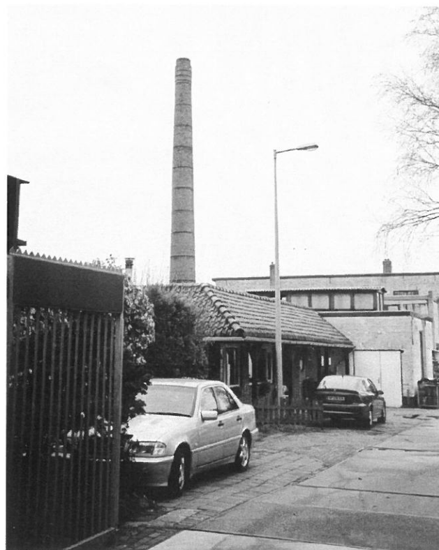
De schoorsteen van de vroegere aardewerkfabriek De Rijn, na 1942 potterij Zaalberg aan het eind van de Hoge Rijndijk. Het terrein is nu in gebruik bij het aannemersbedrijf Bekooy BV. De schoorsteen is een gemeentelijk monument.
