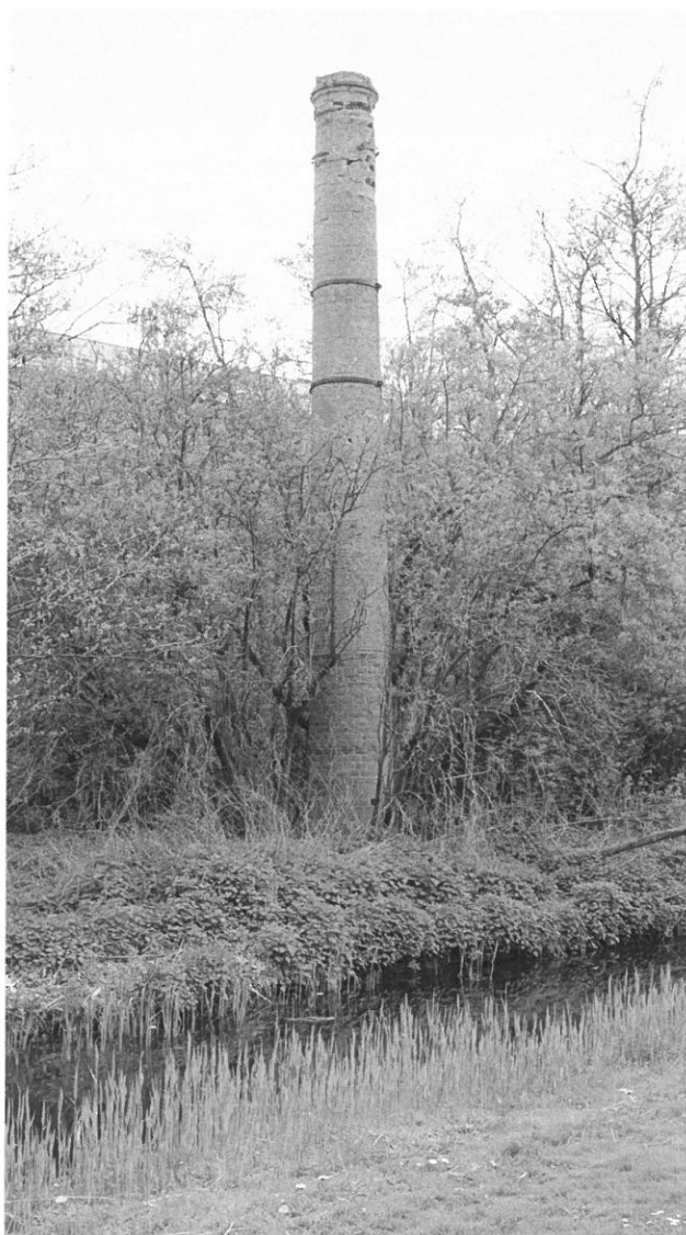
De tuinbouwschoorsteen in Roomburg.
