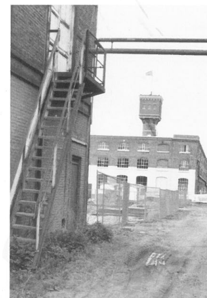
Gezicht op een van de gebouwen met de bedrijfswatertoren.
