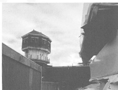
De karakteristieke bedrijfswatertoren van het complex.
