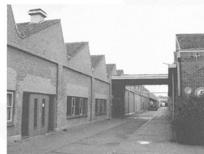
De befaamde sheddaken van de hallen op het oude fabriekscomplex Indië.
