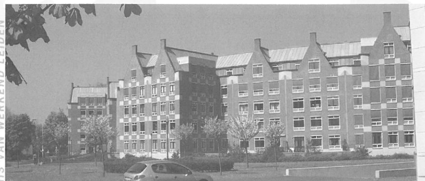
Appartementen in plaats van de grote constructiehal.
