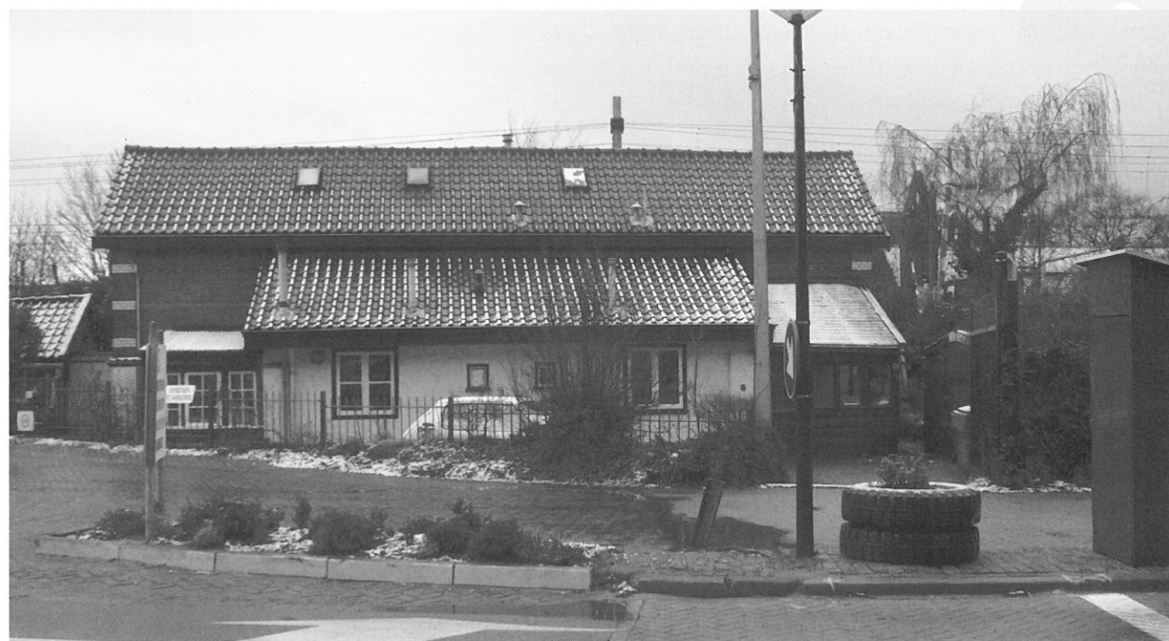
Nog één keer de dubbele wachterswoning, die in opdracht van NS is gesloopt, terwijl de monumentenstatus nabij was.
