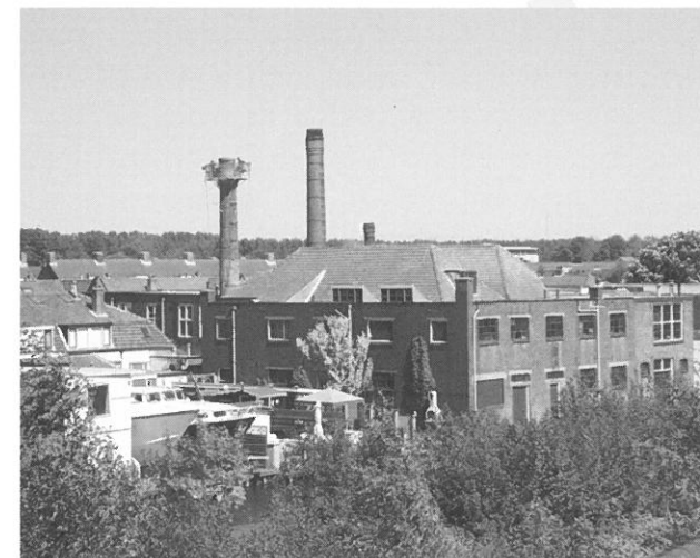
De oudste schoorsteen begon de laatste tijd te hellen en is met behulp van wiggen in 2007 rechtgezet en fraai gerestaureerd, foto Claudia Thunnissen.
