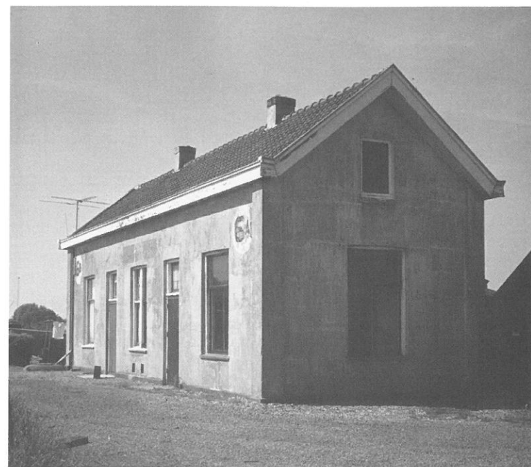
Ook in Zwammerdam stond vele jaren een dubbele spoorwachterswoning, met de nummering 6A en 6B. In 1974 werd dit exemplaar afgebroken. (foto Roelof Hamoen, juni 1972).
