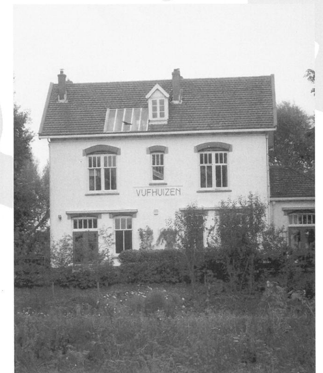
Het vroegere station Vijfhuizen, nu een rijksmonument.
