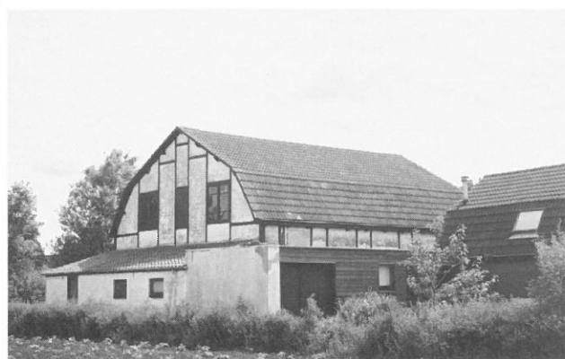
De oude bollenschuur aan de Morsweg.
