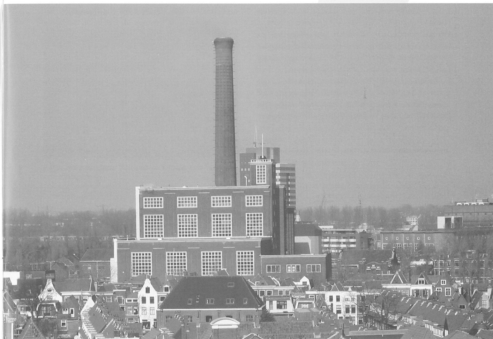
De imposante centrale aan de Langegracht.
