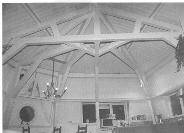
Spinvormige draagbalkenconstructie in dakkapel Steenstraat 6, thans appartement 6D.
