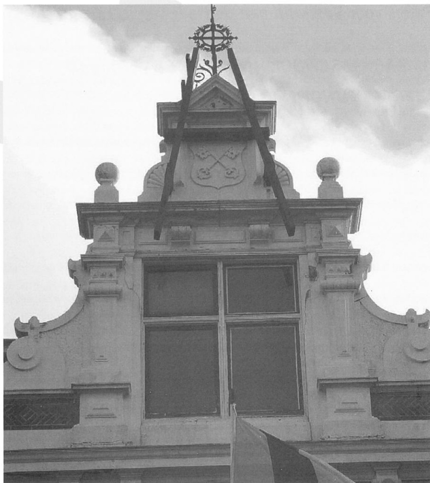
De rijk geornamenteerde geveltop van het gebouw.
