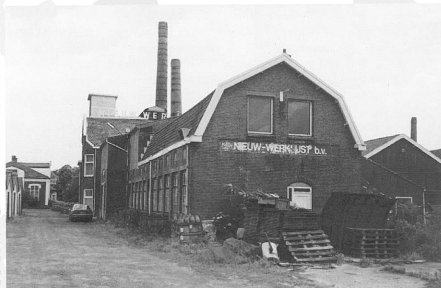
Deel van het fabriekscomplex Nieuw Werklust in Hazerswoude Rijndijk.
