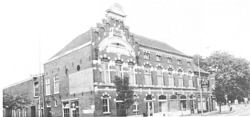
Het Vooruitgebouw vóór de verbouwing
