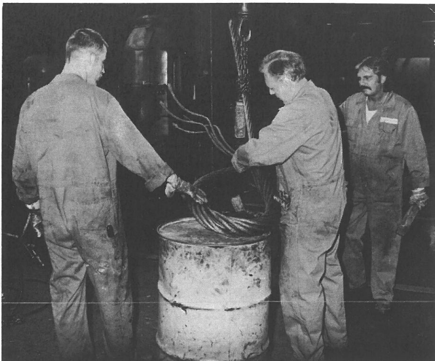
Vervaardigen van een kabeloog
