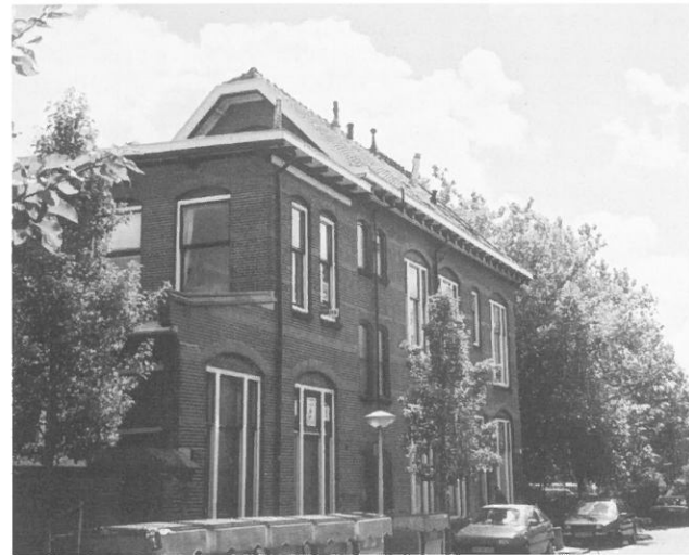
Het administratiegebouw van het vroegere slachthuiscomplex, gebouwd in dezelfde stijl als de directeurswoning.
