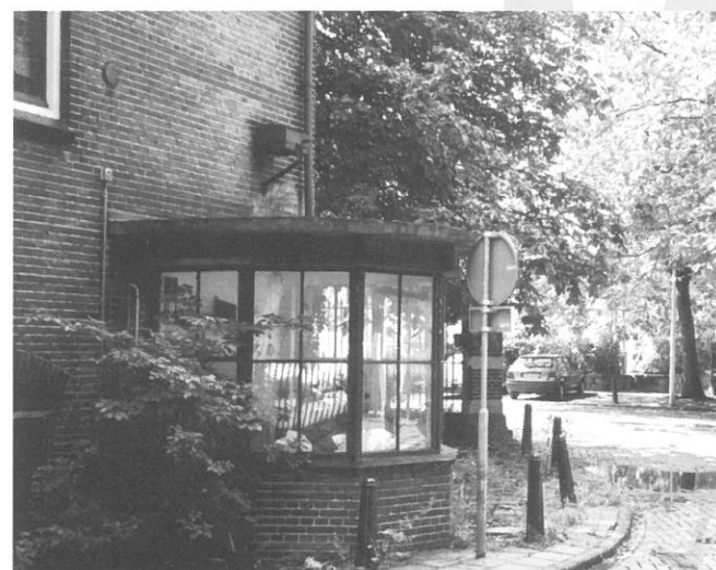
De portiersloge die later is aangebouwd.
