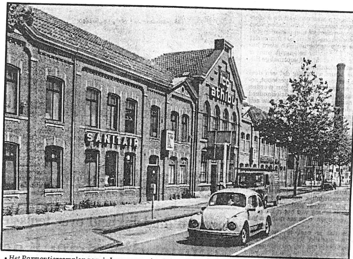
• Het Parmentiercomplex aan de Lammermarkt: slopen of behouden?
