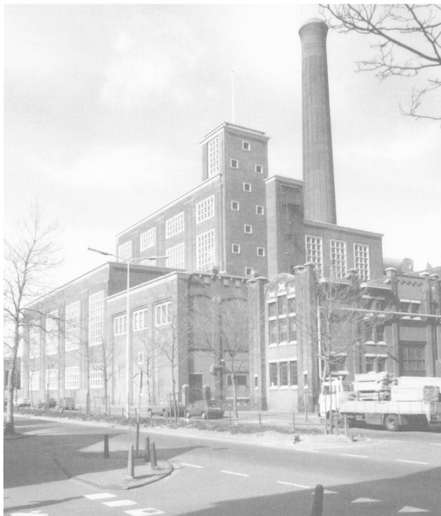
Elektriciteitscentrale aan de Langegracht (archieffoto)
