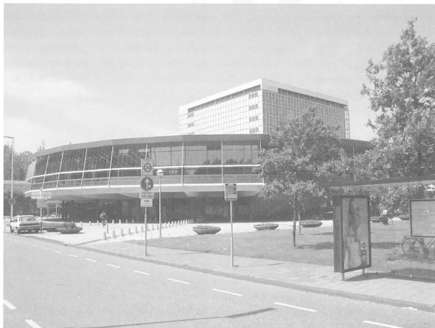
De vliegende schotel met collegezalen en restaurant van het Gorleaus Laboratorium. Foto 2004.
