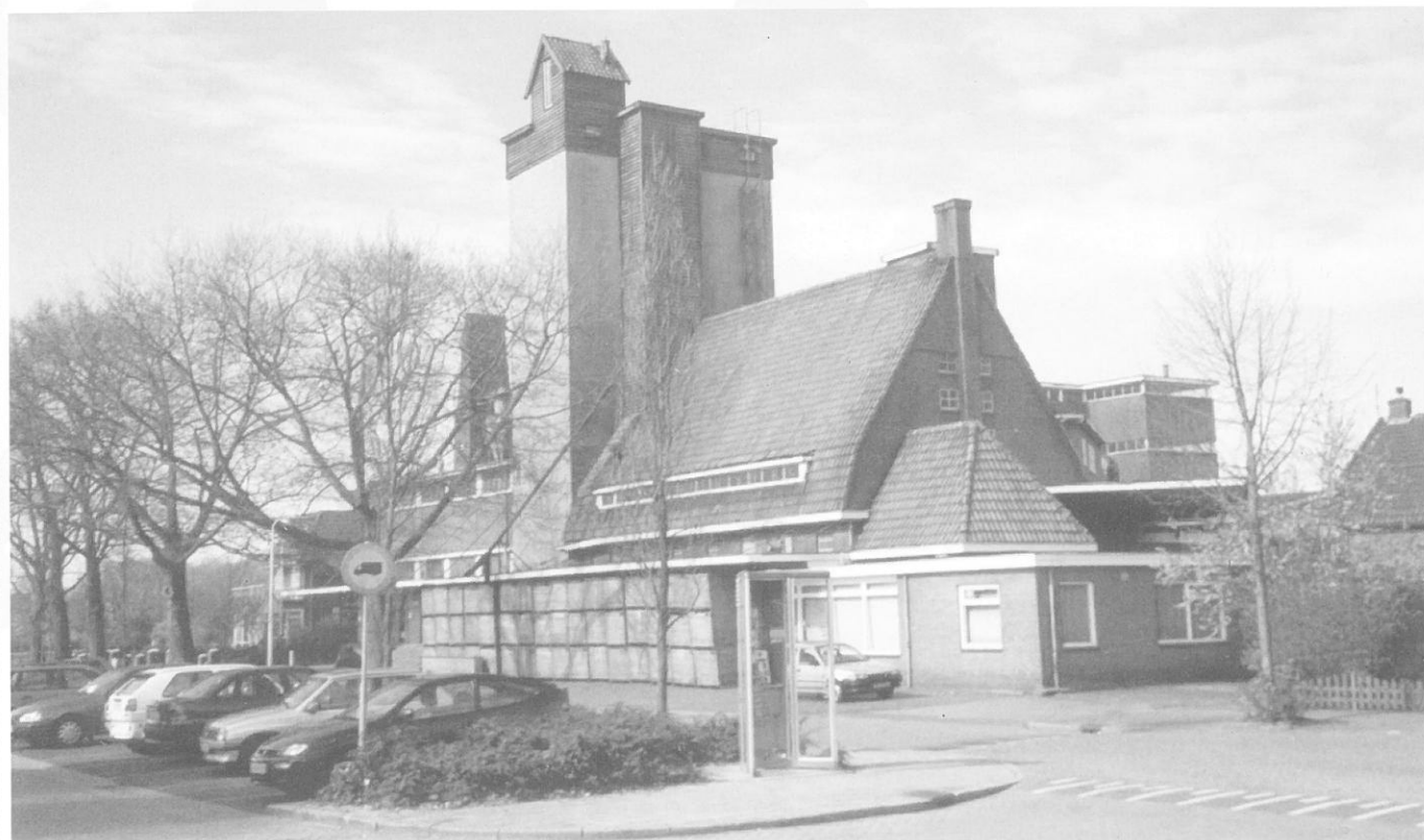
Het silogebouw nabij het station in Mariënborg (Overijssel), genomineerd voor aanwijzing als rijksmonument.
