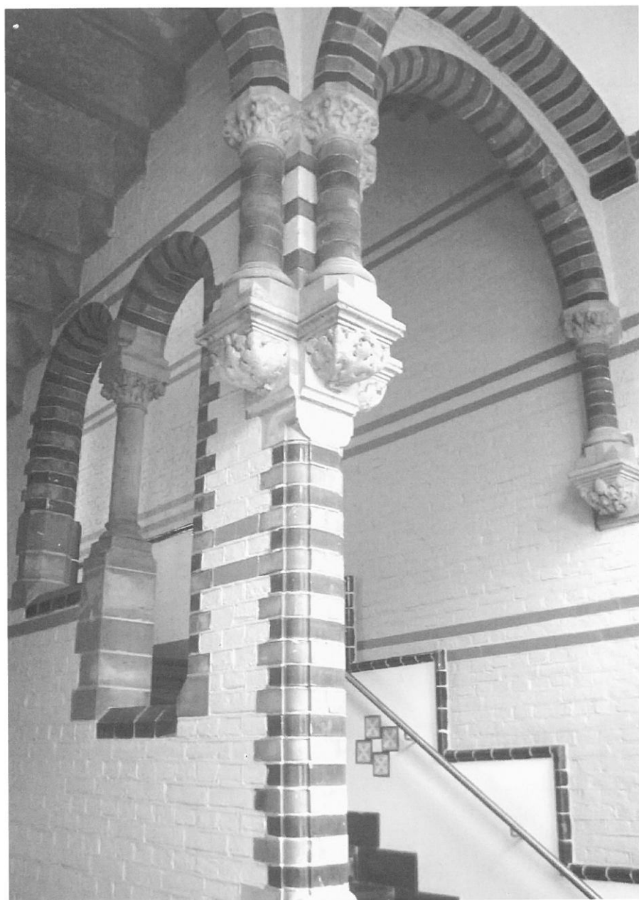
Het trappenhuis van het Pathologisch-Anatomisch Laboratorium, huidige toestand.
