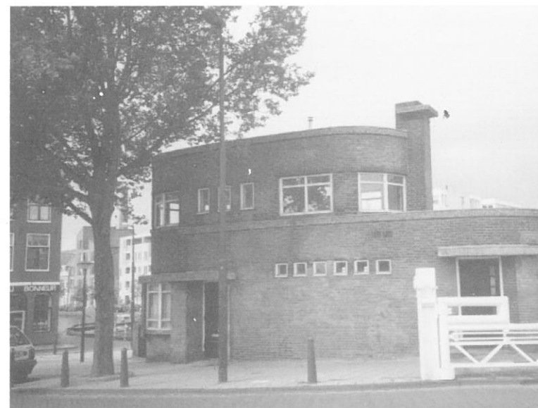
De ronde vormen van de Grote Havenbrug. (foto's W. Burgers)
