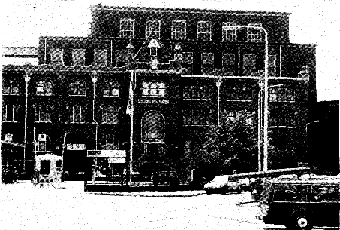
Afb. 38 De centrale in Den Haag: gevel van het dienstgebouw met daarachter het ketelhuis
