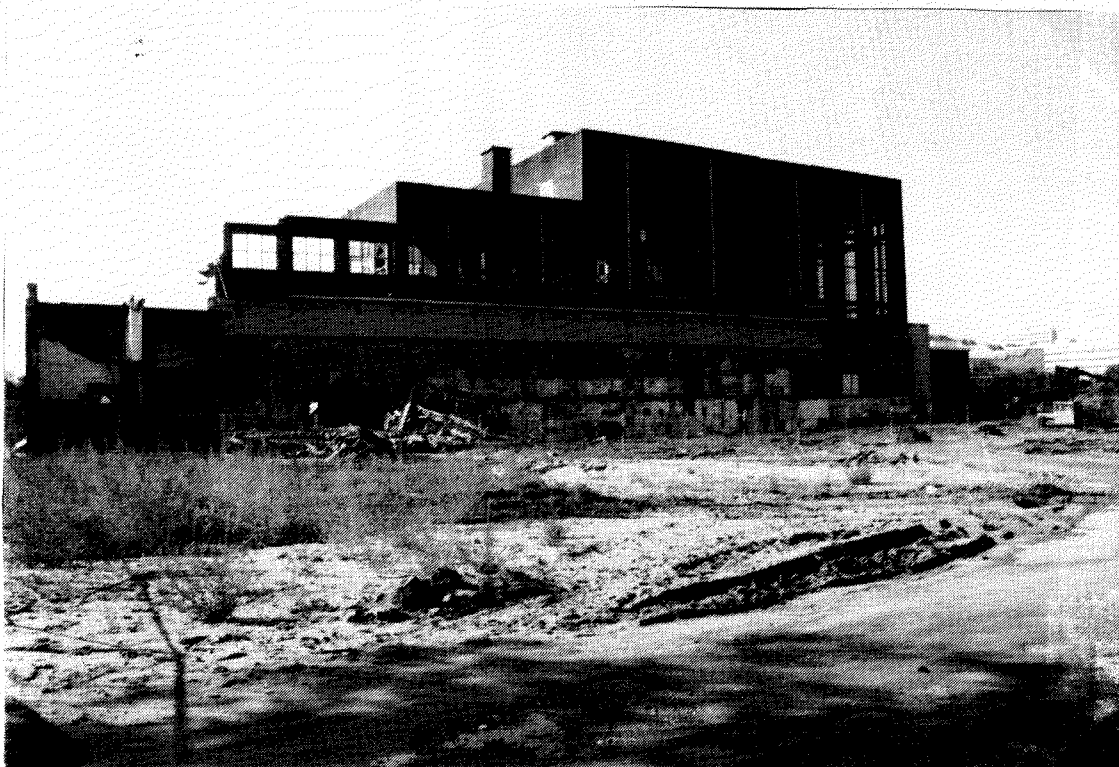
Afb. 48 Op het moment dat we de centrale aan de Nicolaas Beetsstraat in Utrecht bezochten, was de sloop in volle gang.
