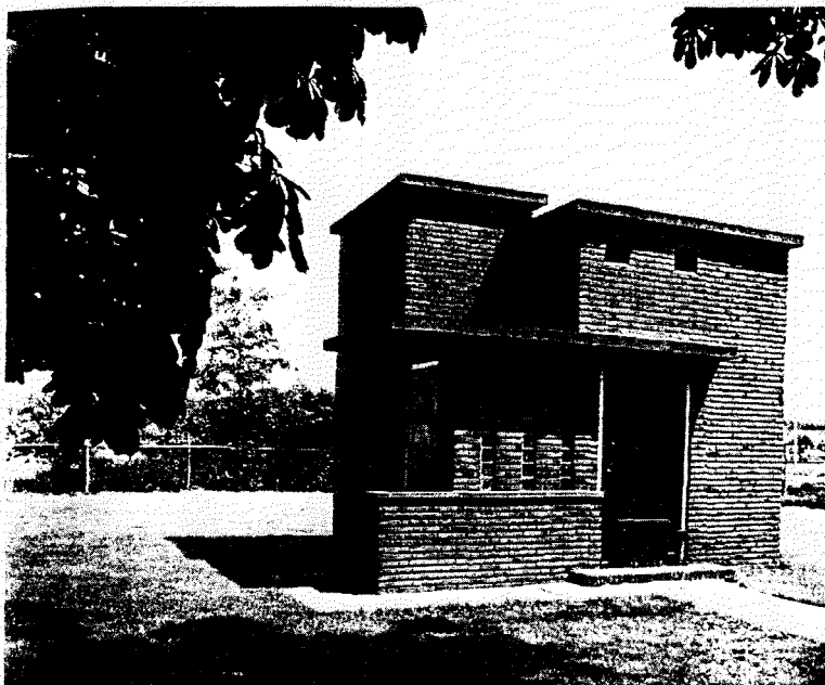
Afb. 15 Kubistisch trafo-huisje uit 1935 aan de Hogeweg in Amersfoort (Roland Blijdenstijn, Trafohuisjes p.45)
