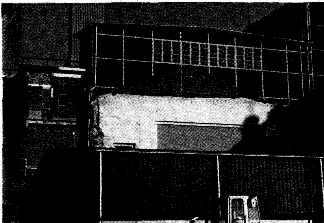
Afb. 41 De Donge-II centrale: aan de sporen op de gevel zie je waar vroeger het gebouw van Donge-I heeft gestaan
