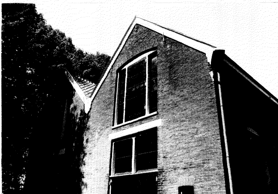
Afb. 34 De centrale in Veenhuizen: voorgevel met twee nokken
