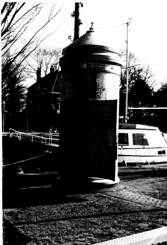
Afb. 44 Trafo-zuil met geopende deur, bij het museum van het energiebedrijf in Amsterdam
