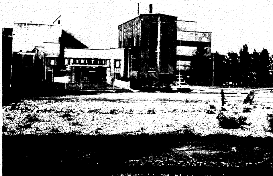
Afbeelding 26. Aan de achterkant van de Nedalco-fabriek in Bergen op Zoom werd de melasse binnen gebracht. Op de achtergrond staat een oude watertoren. Water werd gebruikt om de melasse (een dikke stroop) vloeibaar te maken.
