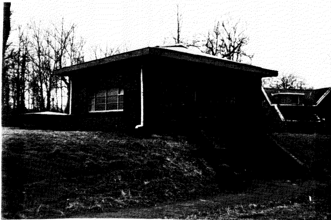
Ingang tot een reinwaterkelder, Pompstation Overveen
