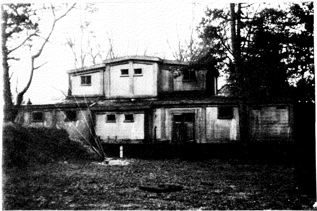
Filtergebouw, Pompstation Bloemendaal
