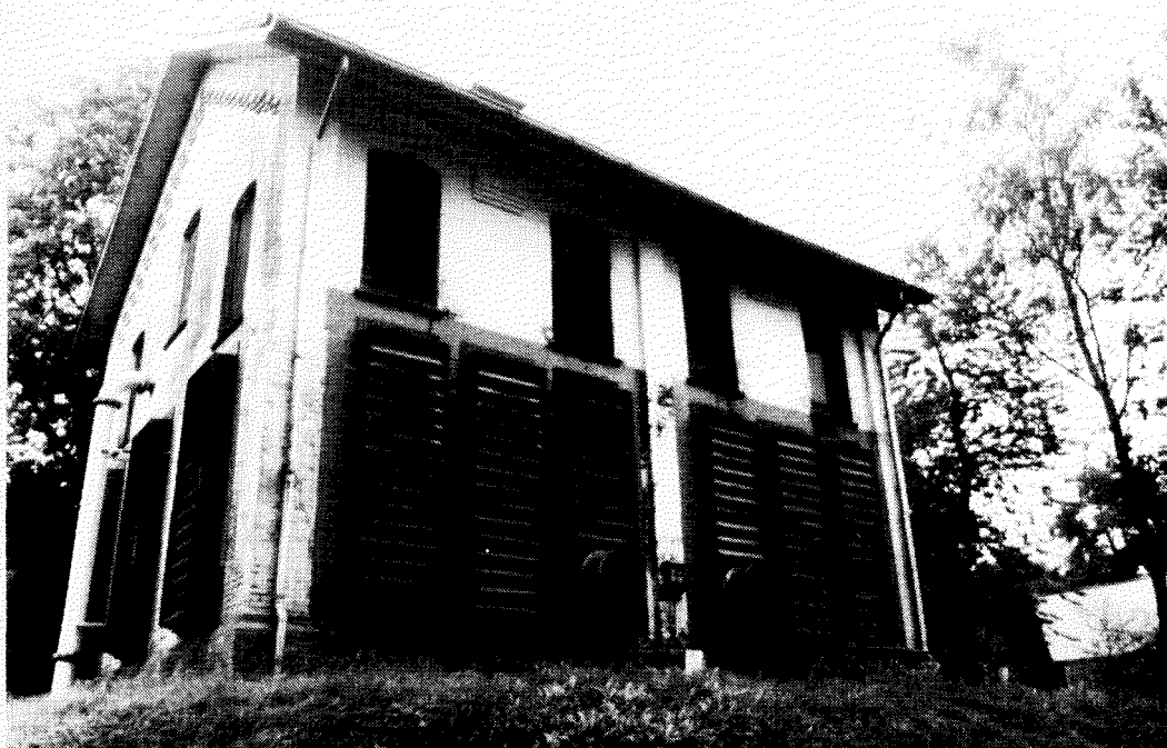
Beluchtingsgebouw, Pompstation Weerloseweg
