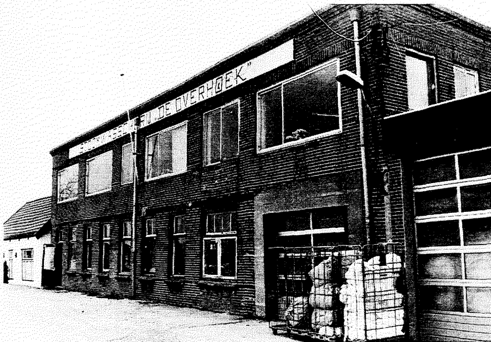
Afb. 29. Zijaanzicht wasserij Overhoek in Nederhorst den Berg.
