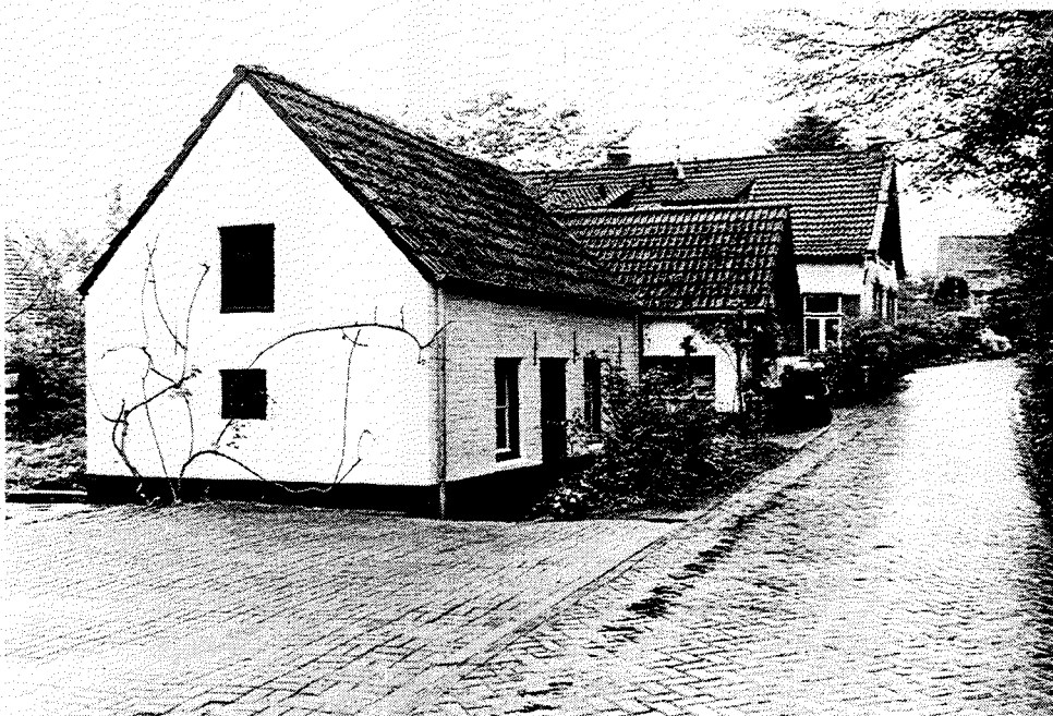
Afb. 19 Achteraanzicht ambachtelijke wasserij aan de kasteelselaan in Ubbergen.
