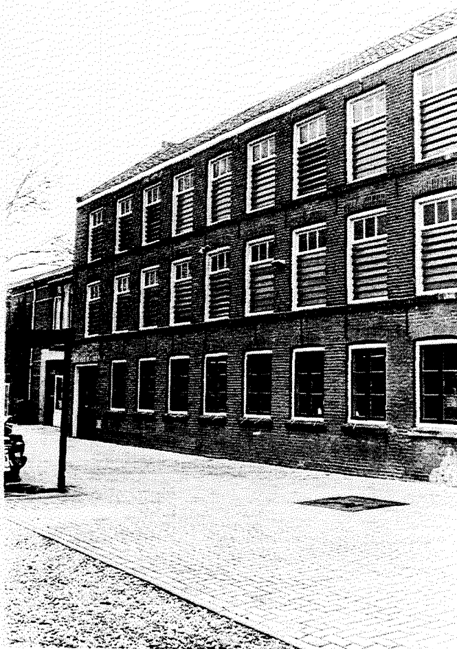
Afb. 22. Bedrijfsgedeelte wasserij Aurora te Utrecht.
