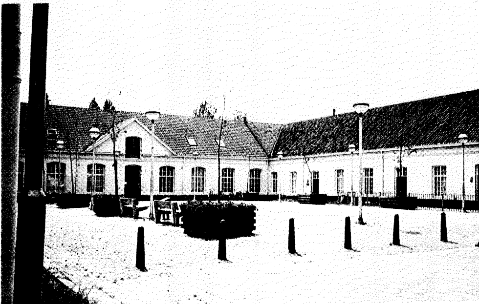
Afb.10: Voormalig BeKa-complex te Tilburg
