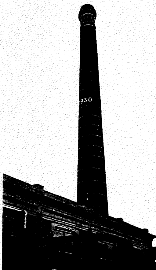
Afb.17: Schoorsteen van de AaBe
