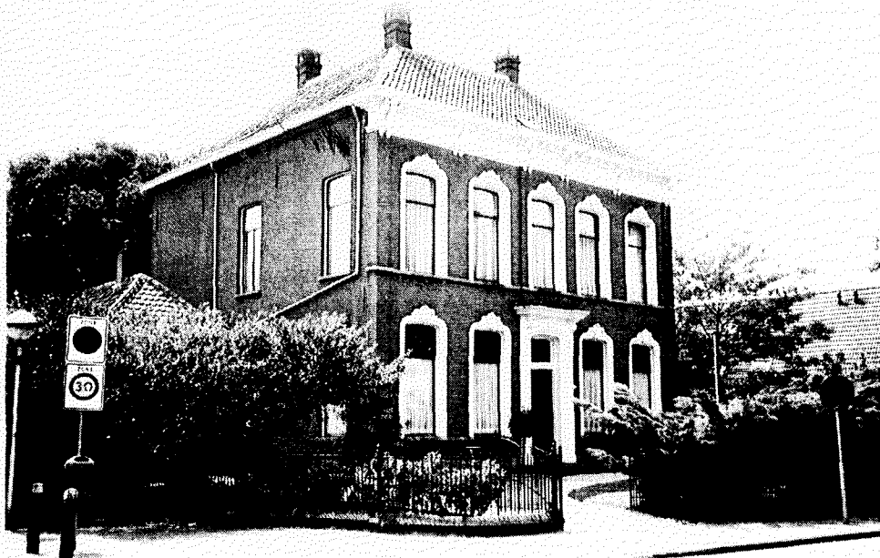
Afb.13: Fabrikantenvilla aan de St.Josephstraat
