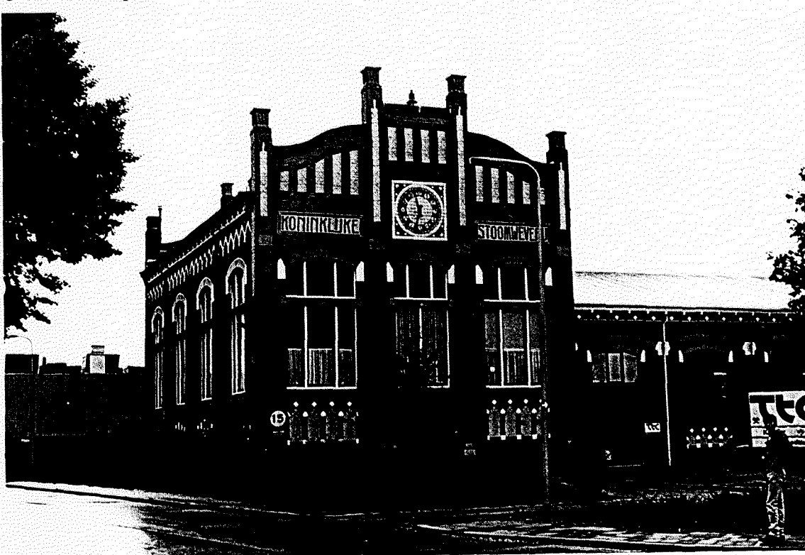
Foto 22. Ketelhuis van de Koninklijke Stoomweverij (KSW) te Nijverdal.
