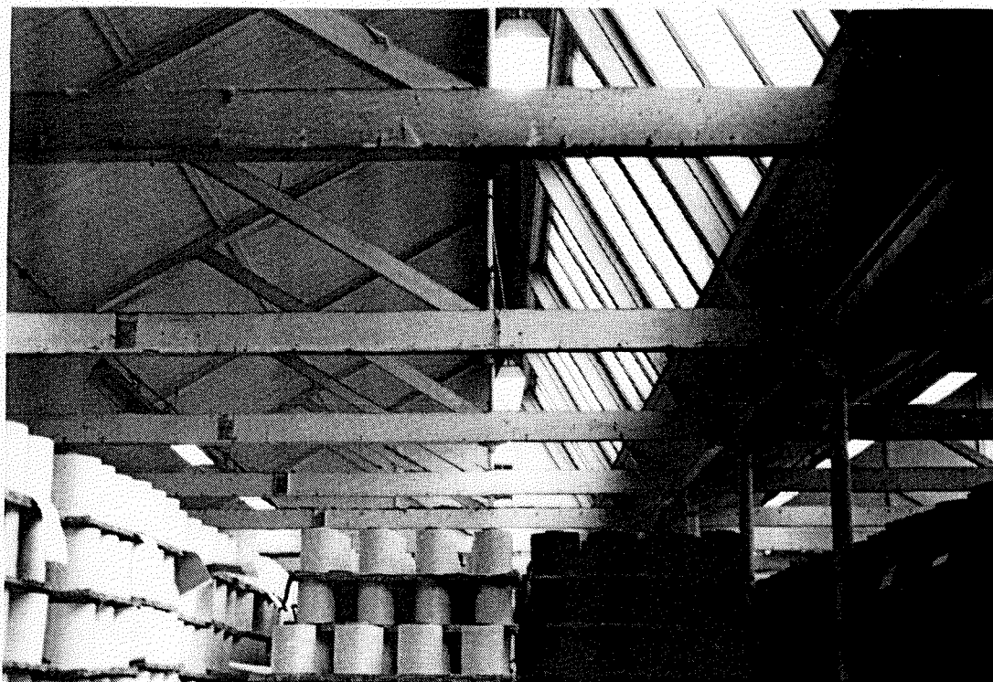
Foto 6. Duidelijk zichtbaar zijn de karakteristieke gietijzeren pilaren.
